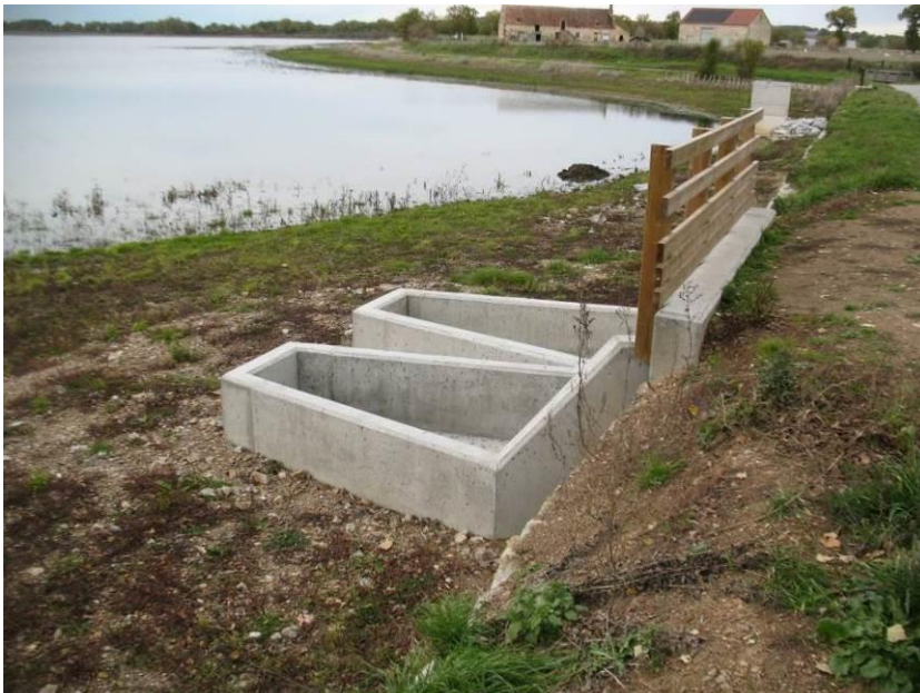
Calé à la cote 205 cm, le nouveau déversoir doit permettre d'évacuer les crues décennales (S. BUR/CD23)
